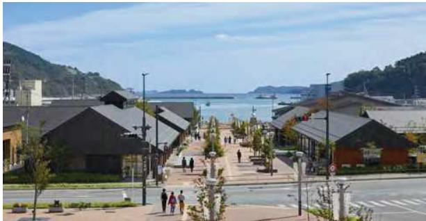
「レンガみち」の幅員は、4.5+6.0+4.5 (= 15m) で構成される。中央部分には、並木と照明灯を二列に配置し、海への眺望軸を形成している。沿道には木造大屋根が特徴的で集客のコア施設である「シーパルピア女川」が立地し、レンガみちへのデッキ張り出しや舗装の滲み出しによって、にぎわいの共有を図っている。
